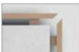
**Conseil :** si vous utilisez le profilé creux comme baguette de finition, un onglet ouvert dissimule les chambres creuses. Tenez toujours compte de la dilatation thermique pour les distances.
