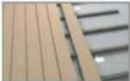
Glisser les raccords de lames sous la lame précédente. Appuyer sur toute la longueur de la lame. L'espacement peut être modifié à souhait à l'aide d'écarteurs.
