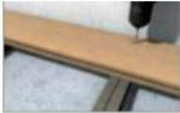
Pré-percer la lame avec un foret de 2 mm.
