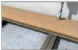
Avec un foret de 12 mm, percer un trou d'environ 1 cm de profondeur (uniquement à travers la paroi supérieure).
