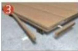
3 Die Leiste eindrücken. Für die Stirnseiten werden passende Leisten aus einem Vollprofil geschnitten
