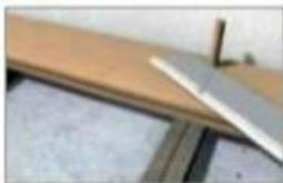
Verser la colle dans le trou, insérer la cheville et couper à ras. Cette procédure n'est effectuée que pour la première lame à chaque intersection avec la latte d'ossature.
